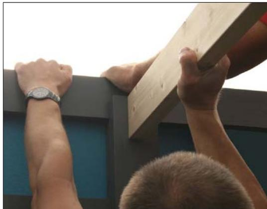
Afin de déterminer avec précision la hauteur de pose de panne et des supports de panne, positionnez une volige dans le sens de la hauteur, depuis le support de voliges à l'avant jusqu'à la panne sablière arrière. Marquez ensuite le bord inférieur de la panne afin de déterminer l'emplacement exact des supports de pannes.
