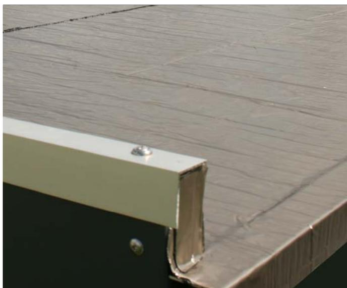
Après collage et roulage des bandes de revêtement, ajustez les bords en les coupant avec un cutter.
