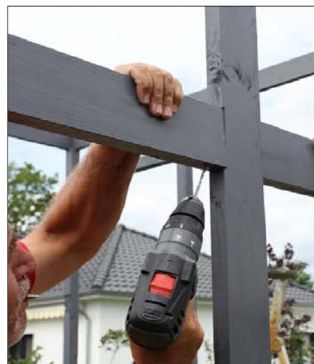
Placez maintenant le premier madrier intermédiaire dans la découpe prévue à cet effet et fixez-le après pré-perçage avec une vis droite C105-0150 traversant le poteau et une vis C105-0100 traversant le madrier intermédiaire en biais par le bas. Vissez en biais en respectant un écartement de 4 cm de la tête de vis par rapport au poteau avant vissage.
