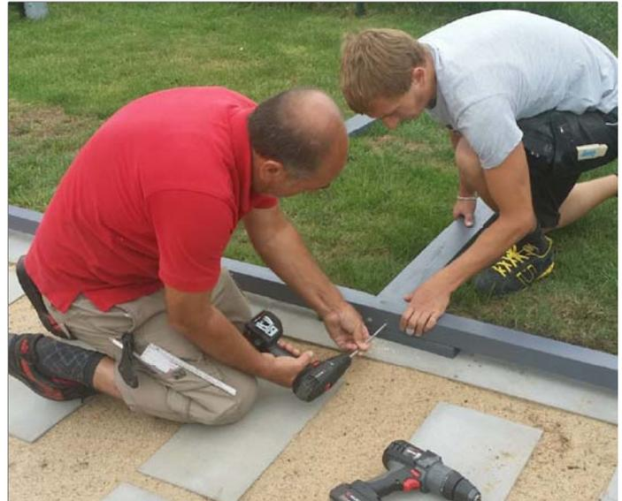
Tournez les madriers de seuil sur le côté, pré-percez les trous pour les vis avec un foret de 4 mm, pour visser ensuite les poteaux intermédiaires par le bas à l'endroit de la découpe en traversant les madriers de seuil avec 2 vis C105-0100.
