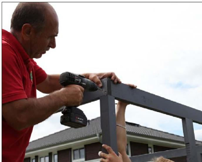
Maintenant vissez ensemble les coins des pannes sablières se trouvant à la même hauteur avec 2 vis C105-0080 après pré-perçage. Écartez les vis à 1,5 cm du bord extérieur.
