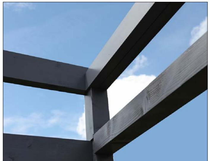
Placez maintenant la traverse de support des voliges sur le poteau d'angle de la façade, pré-percez et vissez-la de l'intérieur contre la panne sablière avec 5 vis C105-0050. Laissez aux extrémités un écart d'env. 5 cm.
