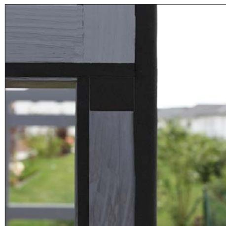
La bande d'étanchéité doit être collée bord à bord pour éviter les infiltrations d'eau ! Collez les bandes d'étanchéité verticales en continu et joignez les bandes horizontales en les ajustant bord à bord. Restez à 0,5 cm du bord en haut !
