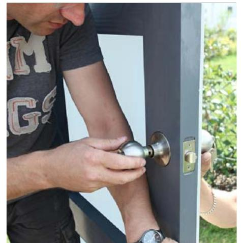
Maintenant, positionnez la pièce métallique de couleur laiton exactement au milieu de la découpe sur la face interne de la porte pour la fixer avec la partie externe de la serrure à l'aide des vis jointes. Emboîtez maintenant le support en acier inoxydable sur la pièce métallique et enfoncez la poignée tournante intérieure. Enfoncez pour cela le ressort à l'aide de la petite tige métallique pour que la poignée puisse s'enclencher.
