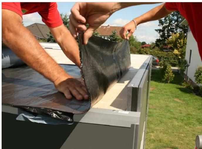
Posez maintenant le revêtement de toiture autocollant. Le revêtement doit être posé transversalement par rapport à la pente du toit. Déroulez environ 100 cm de revêtement et laissez pour l'instant le film de protection sur le revêtement afin de pouvoir ajuster exactement le revêtement. Ce n'est qu'après avoir ajusté exactement le revêtement qu'il faut retirer le film de protection sur 10 cm et fixer le revêtement avec précision.
