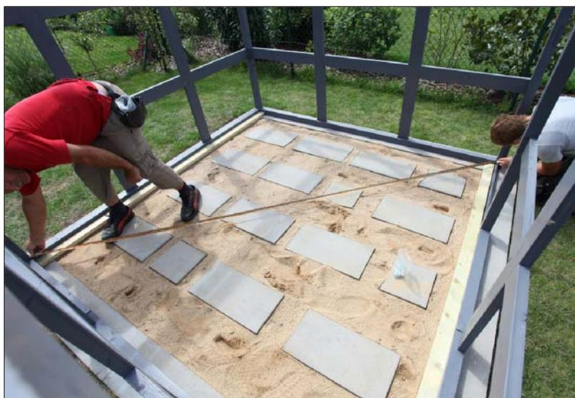
Vérifiez aussi les diagonales à l'aide d'un mètre ruban. Mesurer les diagonales à partir des coins opposés des madriers de seuil, les deux mesures doivent être égales.
