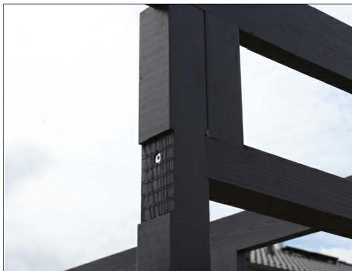
Positionnez maintenant la pièce de bois courte à la verticale, à gauche au-dessus du linteau, pré-percez et fixez-la de l'intérieur au poteau avec 2 vis C105-0100.
