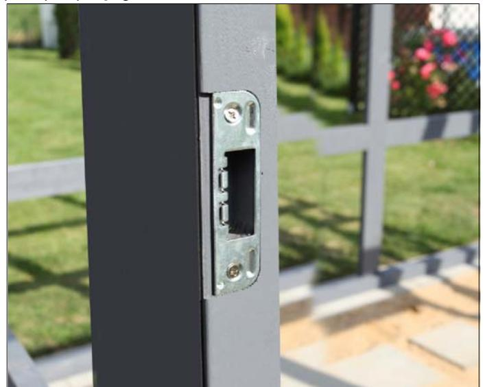
Positionnez ensuite la gâche de la serrure dans la découpe du poteau de porte à gauche et vissez-la avec 2 des vis ci-jointes après pré-perçage.
