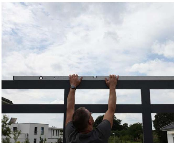
Afin de garantir la pose optimale des plaques de façade assurez-vous avec un niveau à bulle que la construction soit bien de niveau, aussi bien à l'horizontale qu'à la verticale. Vérifiez également la partie haute de la construction.
