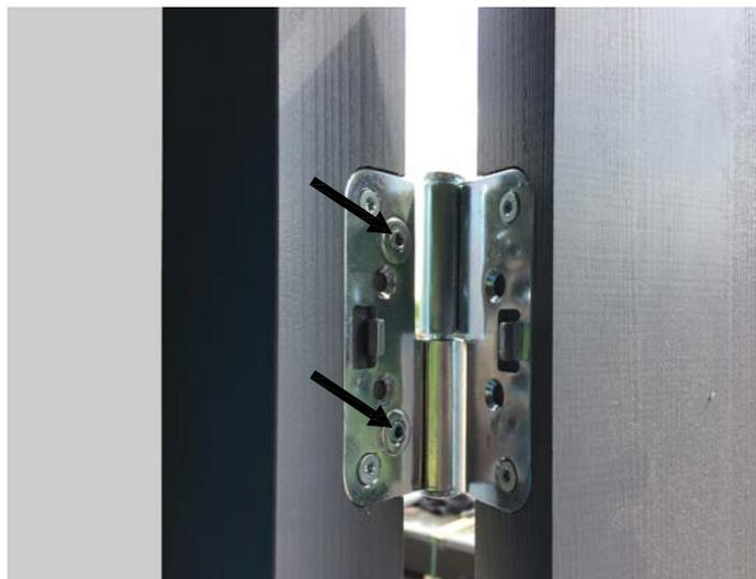
Accrochez maintenant les portes munie des plaques de façade aux paumelles du support de construction.
