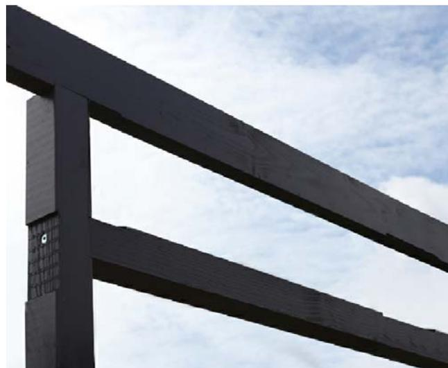
Placez la traverse de bois horizontale du linteau dans les découpes prévues à cet effet, en veillant à affleurer les bords extérieurs des éléments de la construction. Pré-percez et fixez de chaque côté avec 2 vis C105-0100 par l'extérieur en traversant les poteaux. Restez à 4 cm du bord extérieur en vissant. Puis vissez la pièce centrale avec 2x C105-0150 par le dessus et 2x C105-0100 par le bas.
