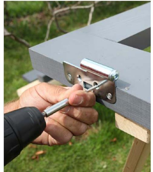
Positionnez la porte laisse du bon côté et fixez maintenant les trois paumelles de la porte (3x droite, 3x gauche) dans les découpes prévues à cet effet avec 4 des vis ci-jointes après pré-perçage.
