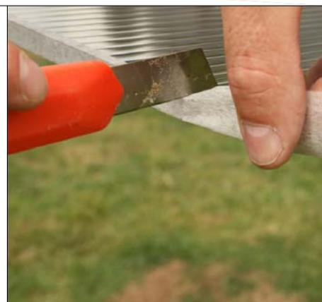
Collez maintenant la bande d'étanchéité C212-105 sur les deux côtés ouverts des doubles plaques alvéolaires afin d'éviter la pénétration d'humidité qui causerait une buée de condensation inesthétique.
