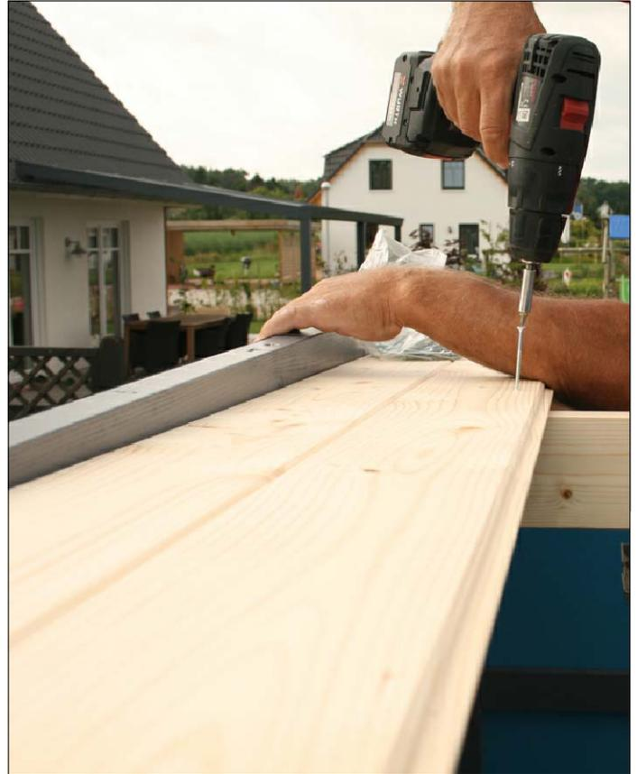
Après avoir pré-percé, vissez les voliges profilées avec chaque fois 2 vis C105-0040 devant sur la traverse derrière la panne sablière, sur les deux pannes et sur la panne sablière à l'arrière. Le voligeage doit dépasser à l'arrière du toit afin de pouvoir fixer éventuellement une gouttière (en option).
