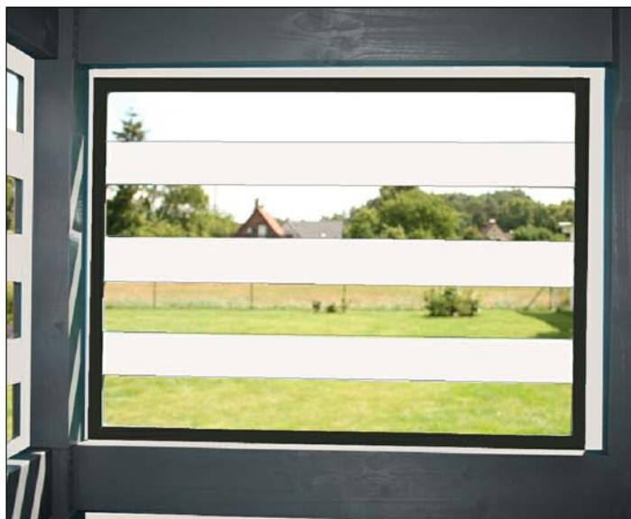
Collez maintenant la bande EPDM A109 à l'intérieur sur les côtés des plaques de fenêtres de la façade pour assurer l'étanchéité. (Commencez directement à ras des ouvertures). Collez ensuite les bandes de joint manquantes en haut et en bas en les ajustant bien contre les joints latéraux.
