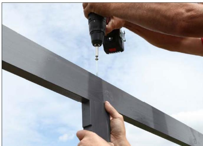
Insérez ensuite les poteaux intermédiaires et les poteaux d'angle dans les découpes respectives de la panne sablière, pré-percez et fixez les poteaux par le dessus des pannes en utilisant chaque fois 2 vis C105-0150.
