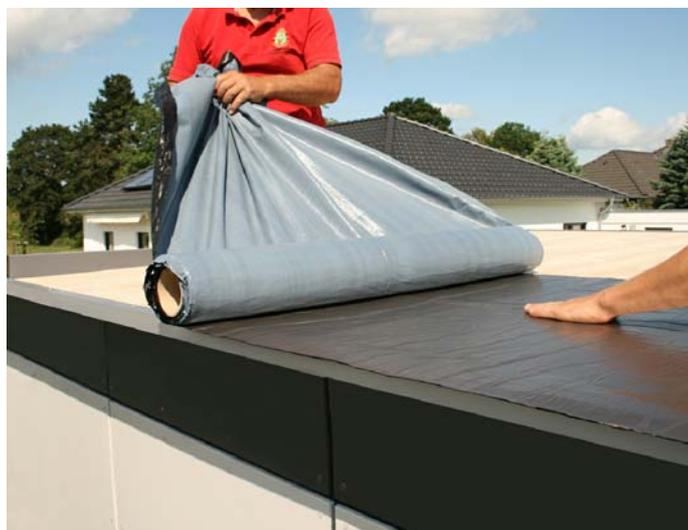
Laissez dépasser du bord assez de revêtement pour garantir une bonne finition de bordure. Avec avoir entièrement collé la première bande, posez la deuxième bande en recouvrant la première sur 20 cm. Vous garantirez un bon collage en passant un rouleau sur la zone de recouvrement.
