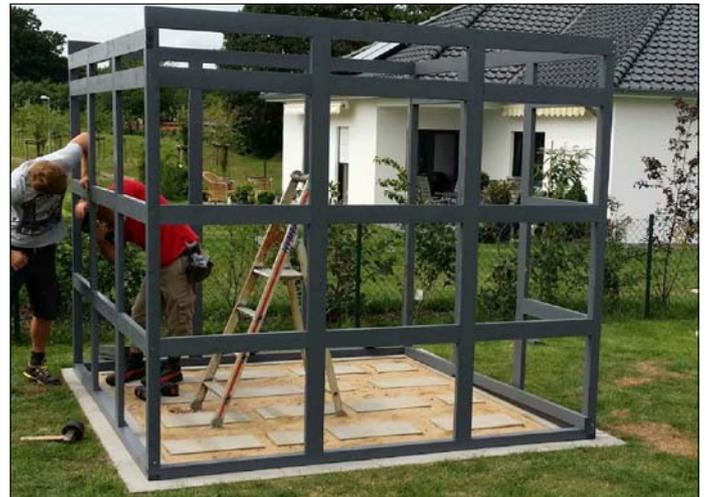
Vissez les madriers intermédiaires des bords en traversant les poteaux après pré-perçage avec des vis C105-0100. Vissez les vis intérieures en traversant les madriers intermédiaires en biais par le bas dans les poteaux intermédiaires respectifs.
