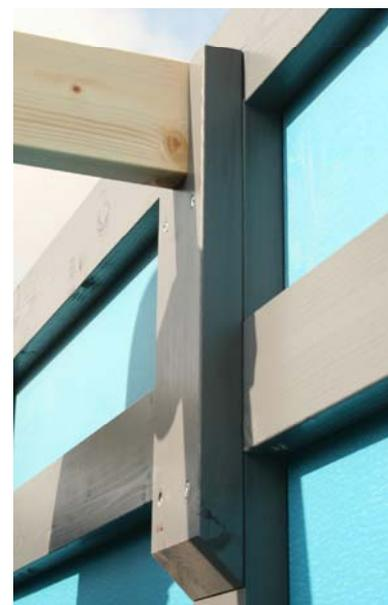
Posez le panne dans les découpes des supports et vissez le panne après pré-perçage de l'intérieur à travers les supports de panne avec chaque fois une vis C105-0080.
