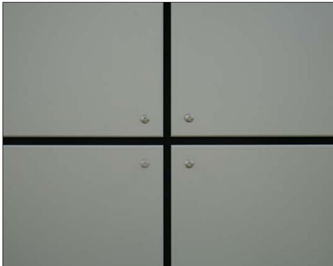
Ajustez soigneusement les plaques à angle droit afin d'avoir un bel aspect régulier des joints sur l'ensemble du bâtiment. Fixez maintenant le madrier de seuil de la façade du bâtiment aux fondations.
