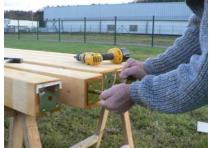
MISE EN PLACE DE LA PLATINE SOUS POTEAUX PAR VISSAGE. 2 DROITES POUR LES POTEAUX MILIEU 4 ANGLES POUR LES AUTRES POTEAUX.
