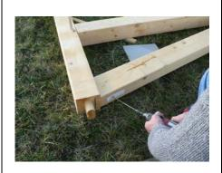
VISSAGE POUR RENFORCER ASSEMBLAGE DE LA PIECE (10) AVEC PIECE (1) par VBA 6 X 200
