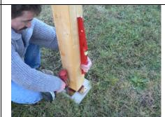
METTRE L'ENSEMBLE DE NIVEAU ET D'APLOMP AVANT DE FIXER LES PLATINES SUR LES PLOTS BETON A L AIDE DES CHEVILLES ET TIREFONDS FOURNIS DANS LE KIT'S.
