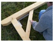
LAISSEZ UN JEUX DE 35 MM ENTRE LE DESSUS DE LA PIECE (9) ET LE DESSUS DE LA PIECE (12). METTRE L'ENSEMBLE D'EQUERRE AVANT DE VISSER CELUI-CI PAR VBA 6 X 140
