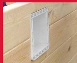
2 - Quand la structure est montée, fixer le premier joint sur le skimmer à l'aide des 4 vis à tête bombée (utiliser le 2ème et le 4ème trou en haut et en bas du joint)
