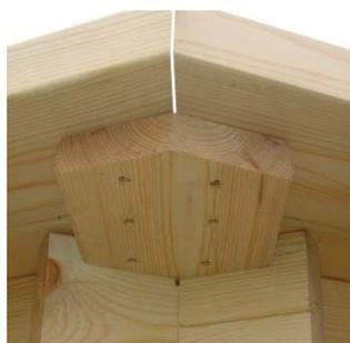
On utilise les caches « L57 » dans les coins de l'ossature bois afin de protéger les lisières pointues (à voir sur une photo à côté). On les monte à l'aide des vis A2 1-1016 torx 4x45, 4 pièces pour chaque « L57 », indispensablement une vis au premier et au dernier madrier, les deux qui restent disposées de manière symétrique. Voici une façon d'installer un cache « L57 » sur le coin de la paroi de la piscine.
