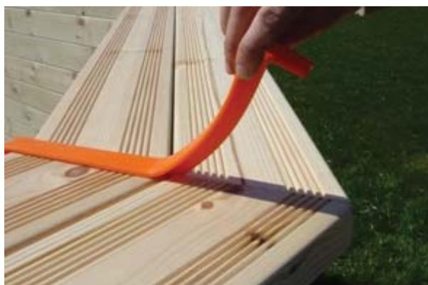
Après avoir monté les margelles, on passe au montage des protections silicone. (En option)
